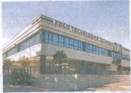
A sinistra Maurizio Grasso, direttore commerciale DAB Sistemi Integrati: "Obiettivo della "security" è proteggere il know-how, le infrastrutture, gli impianti, le materie prime, i prodotti, le persone". Accanto particolare del Polo Tecnologico della Sicurezza del Gruppo DAB
